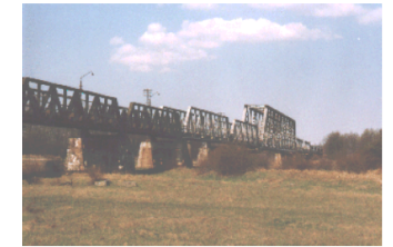
Widok ogólny obiektu
